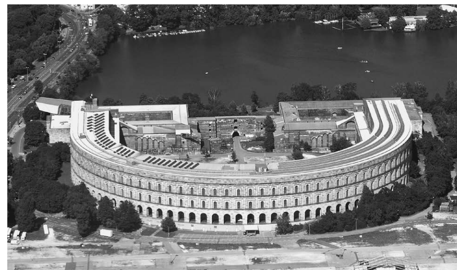
In der Bauruine der Kongresshalle entstand 2001 das Dokumentationszentrum Reichsparteitagsgelände mit einer sehenswerten Ausstellung.
